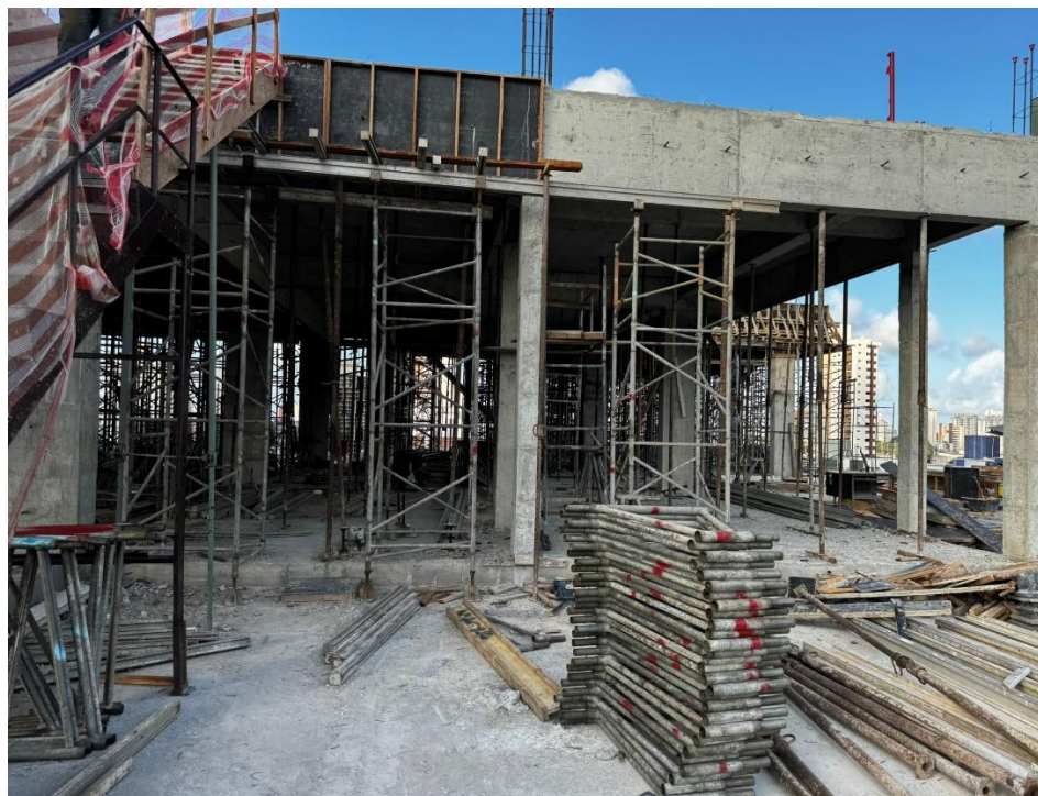
Figura 4. Estrutura para escoramento da laje de cobertura do pavimento térreo.
