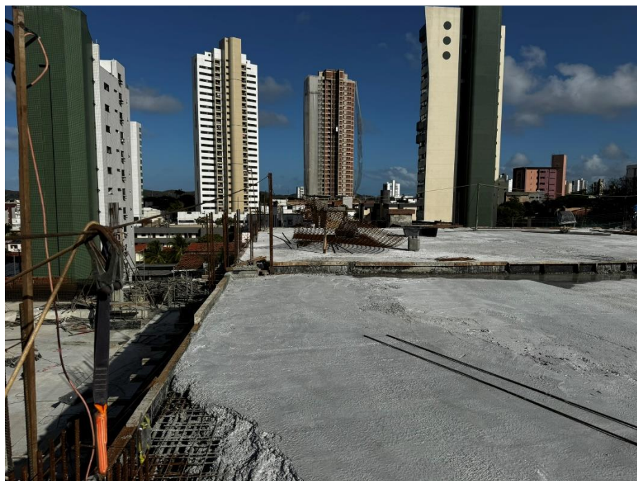
Figura 6. Laje de cobertura do pavimento térreo..
