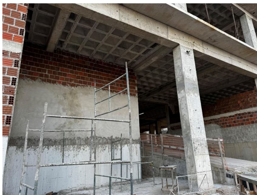
Figura 3. Andaimes tipo torre para execução das alvenarias e revestimentos..
