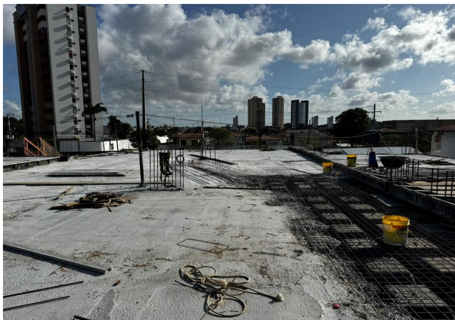
Figura 7. Montagem e concretagem de parte da laje de cobertura do pavimento térreo.
