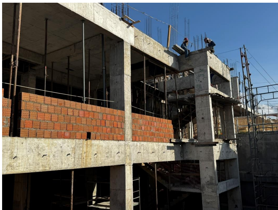
Figura 2. Linhas de vida para proteção dos trabalhadores.
