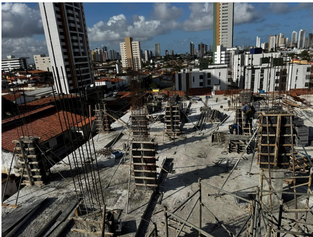
Figura 13. Instalação das hastes de aterramento nos pilares do pavimento térreo.
